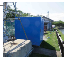
コンクリートの重石で照明塔を支えている様子
