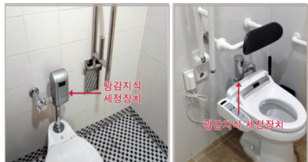
대변기 세정장치를 광감지식으로 설치한 사례 사진
