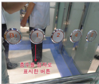
조작 설비가 층수 등을 점자로 표시한 버튼식을 설치한 사례 사진
