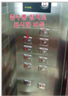
조작 설비가 층수 등을 점자로 표시한 버튼식을 설치한 사례 사진
