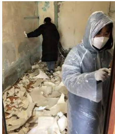
영주맨션 공사 사진
