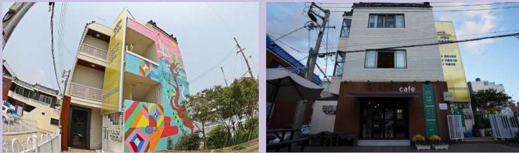
수영성 박물관 건물 외벽
