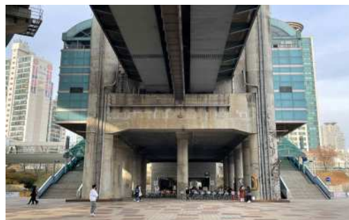
【그림V-193】2층 한강방향 교각 구조물
