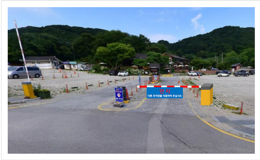
[그림 5-8] 남문주차장 만차 차단봉 설치 예시
