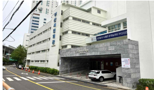
부산시민회관 후면 전경
