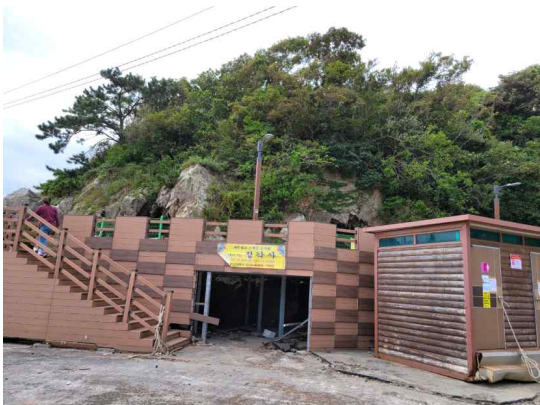
진입 계단 전경
