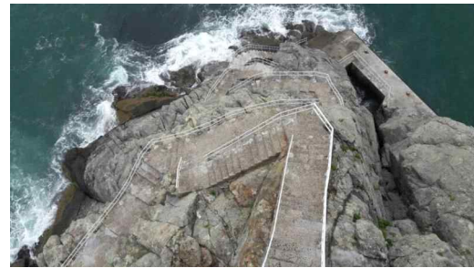
태풍에 부서지고 사라져 새로 설치한 등대계단 난간 (부산=연합뉴스) 이영희 기자 = 오륙도등대 선착장에서 등대건물로 오르는 계단의 난간. 태풍 차바 때 230m가 부서지고 사라져 새로 설치했다. 2017.6.28
