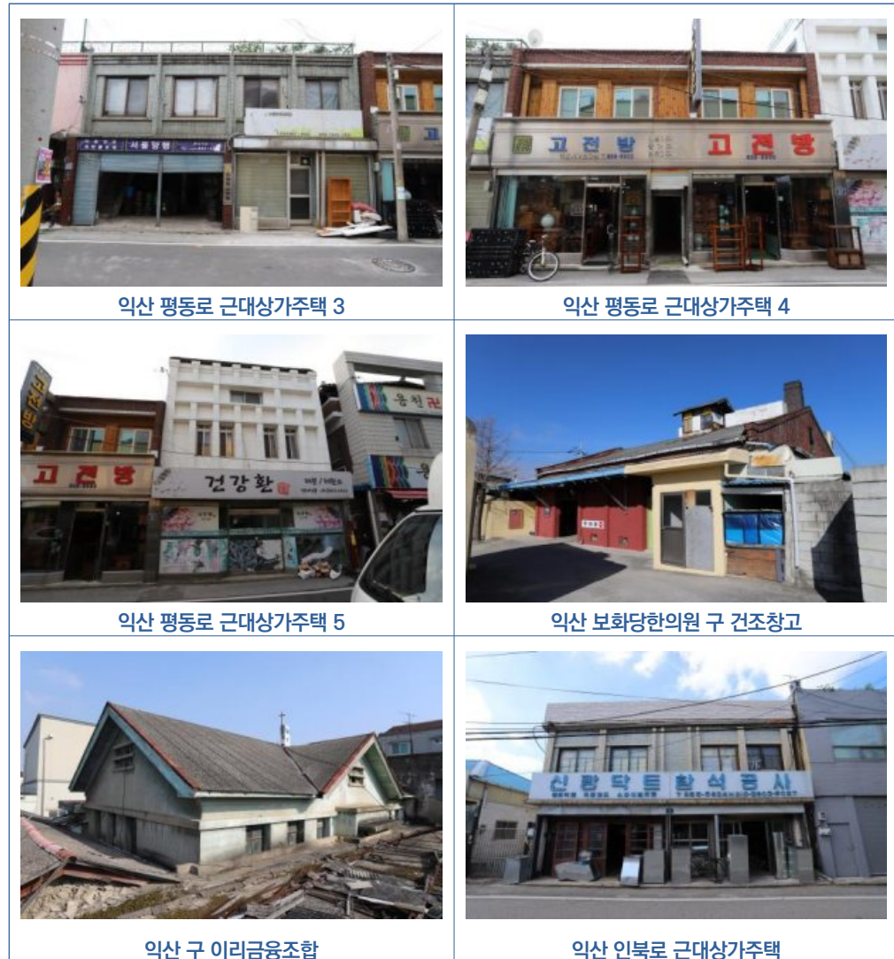
[그림 3-18] 익산 송리 근대역사문화공간 내 개별 국가등록문화재 10개소 현황
