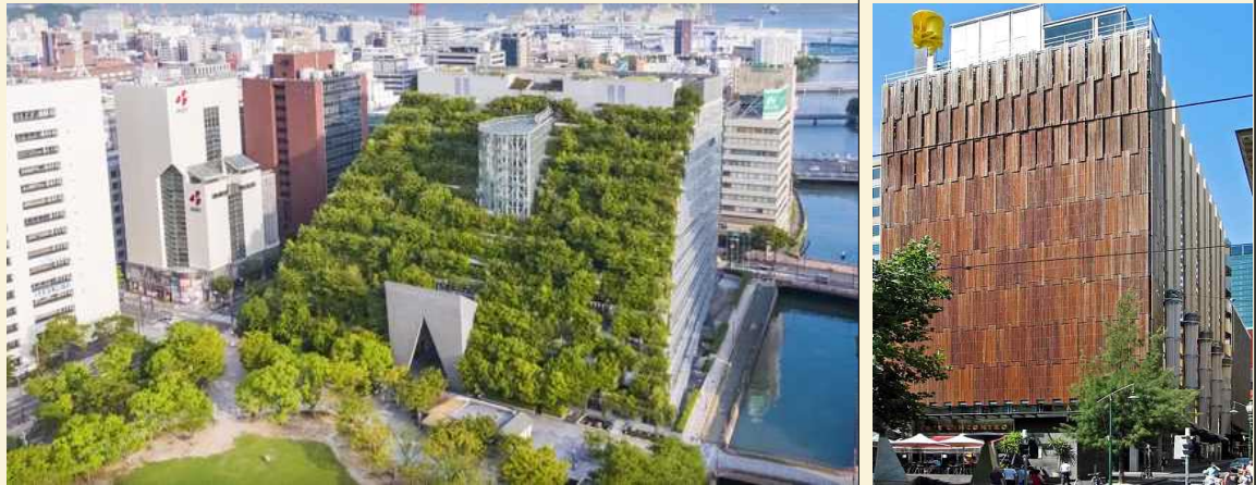
친환경 건축물 사례(좌)_일본 후쿠오카 아크로스의 녹색 커튼(외벽을 따라 옥상까지 이어진 계단식 옥상정원) 친환경 건축물 사례(우)_멜버른 시청(건물 정면 벽 전체에 재생 목재로 만든 차양을 설치해 여름철 햇 빛 차단, 목재 차양은 태양 전지를 사용해 햇빛의 양에 따라 자동 개폐)
