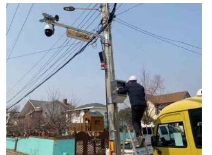
마을 안심골목길 조성사업(방범용 CCTV 설치)
