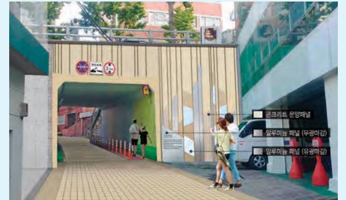
옹벽 개선 후
