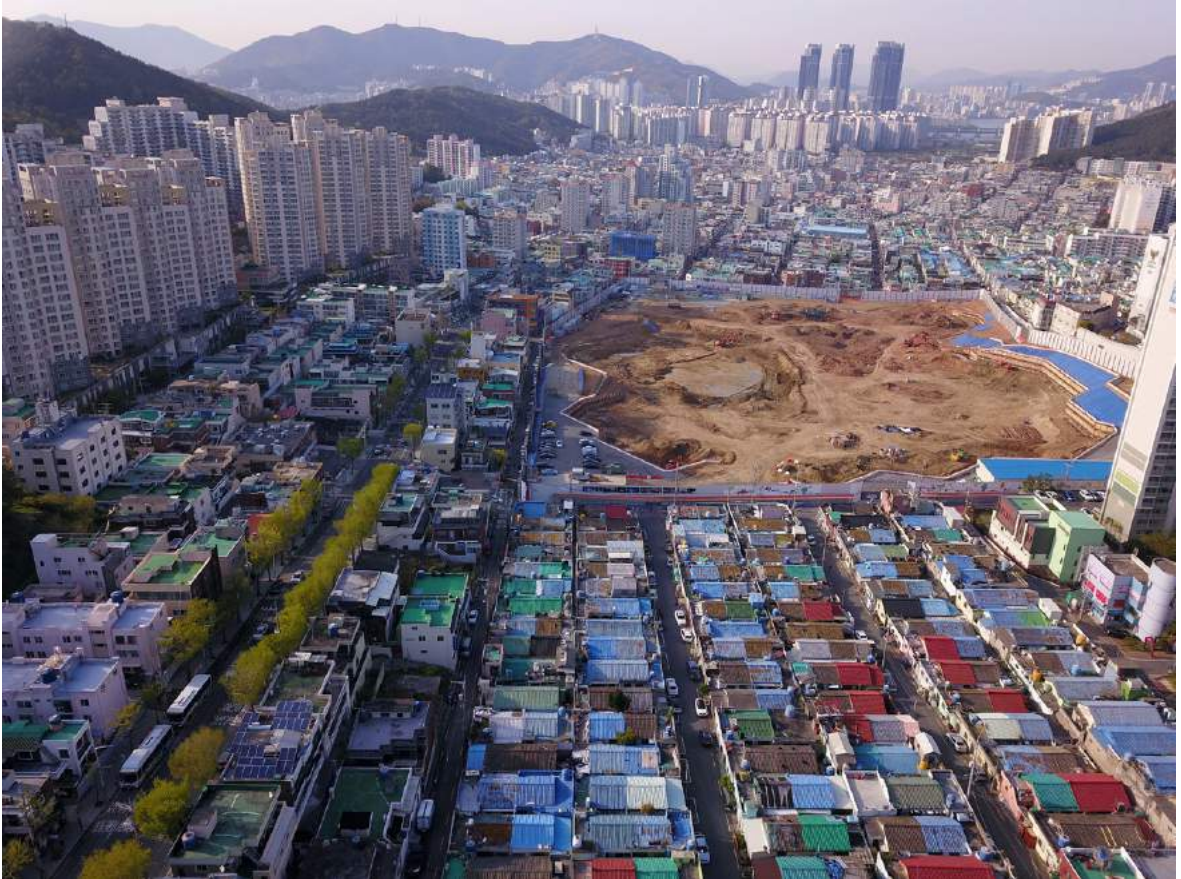
» 아파트 기초공사 중인 용호지구
